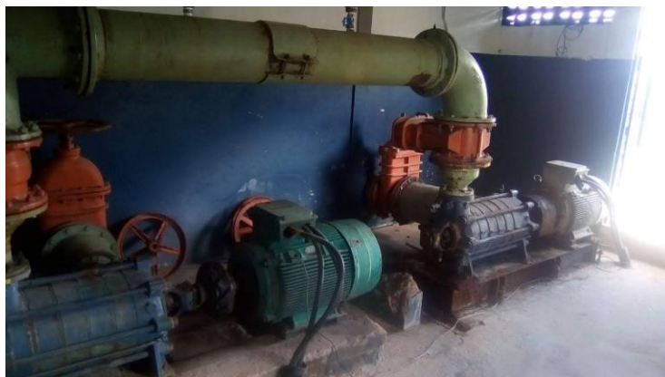
Figura 46 – EEAT Tapera - Monte Santo; EMBASA 2021.
