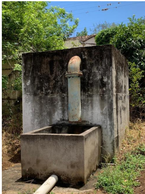
Figura 12 – Caixa de Passagem 20 m 3 - Monte Santo; EMBASA 2021.
