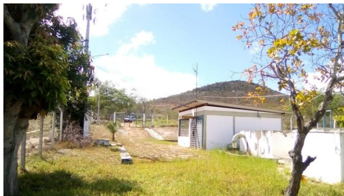
Figura 24 – EEAT Tapera - Monte Santo; EMBASA 2021.
