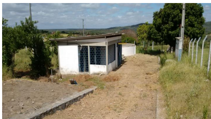
Figura 35 – EEAT Tapera - Monte Santo; EMBASA 2021.
