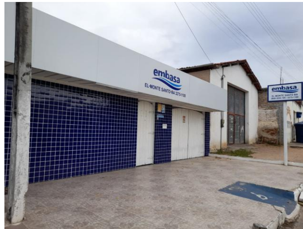
Figura 13 – Escritório Local - Monte Santo; EMBASA 2021.
